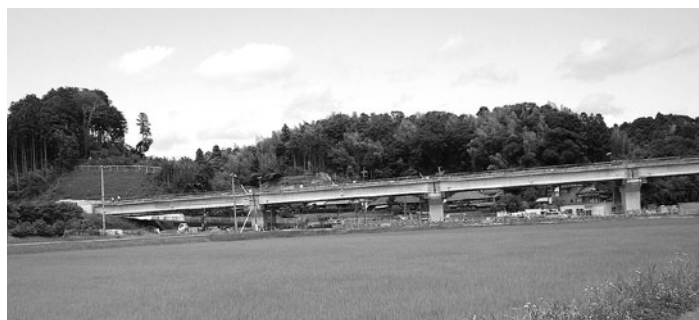
▲建設中の長生グリーンライン（坂本地先）
