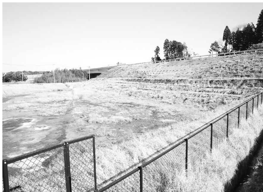
▲関原地先の調整池
