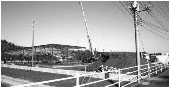
ドラッグストア建設現場の様子
