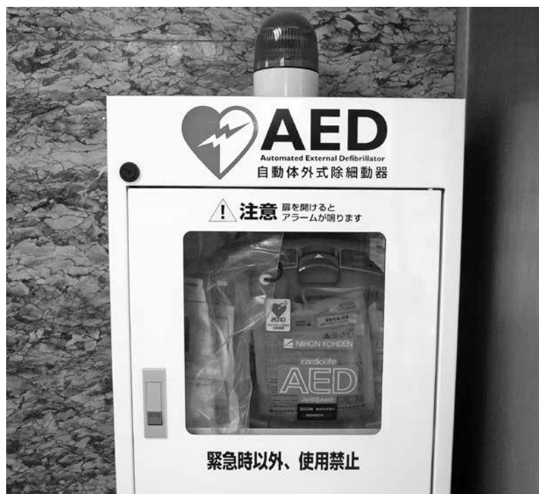
役場正面玄関に設置しているAED
