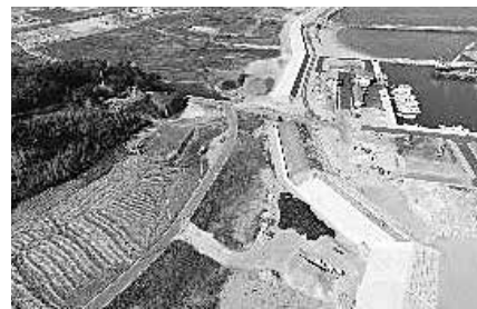
構築中の防潮堤
