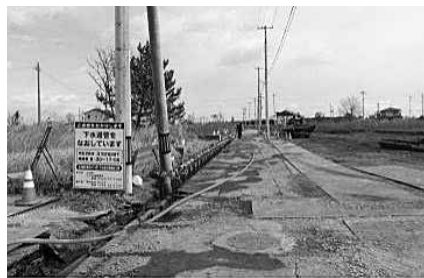
復旧中の道路
