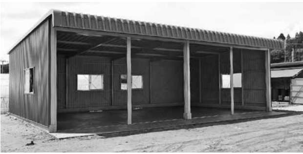
町地域農業整備事業補助金を活用し整備した西部営農組合の倉庫
