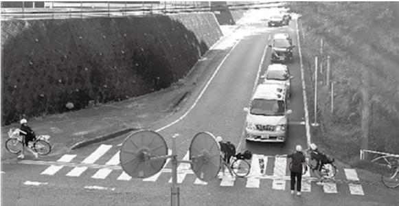
安心安全な通学路整備と大型車の通行整備のため、コンクリートブロックを積み直し、道路幅を拡張するものです。
