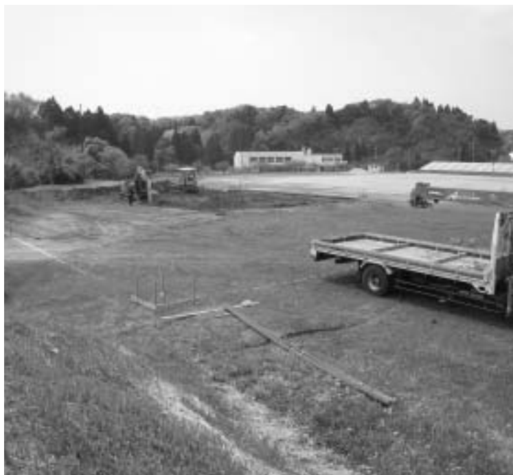
ドクターヘリ離発着場整備工事（陸上競技場上段）
