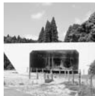
町道の分断を避けるためにボックスカルバートを設置 (写真5)
