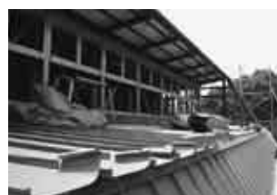
屋根張り工事中 フッ素樹脂塗装のステンレス鋼板を使用
