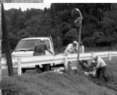
土のう積みによる路肩の補修。（千手堂地先）
