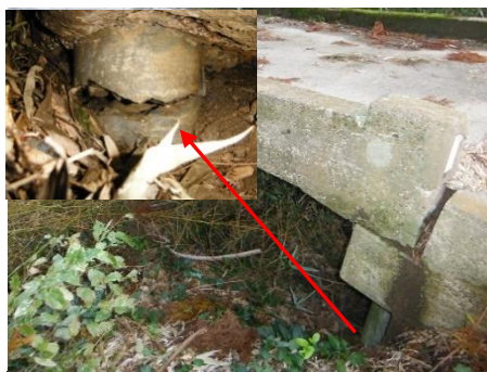
No.81 松ノ関橋【健全性Ⅳ】 （下部工）変形・欠損 ※2021年 架替済
