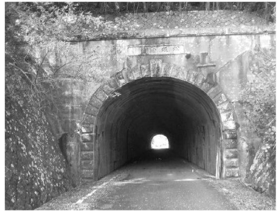
写真-1 松坂隧道(徳島県側)
