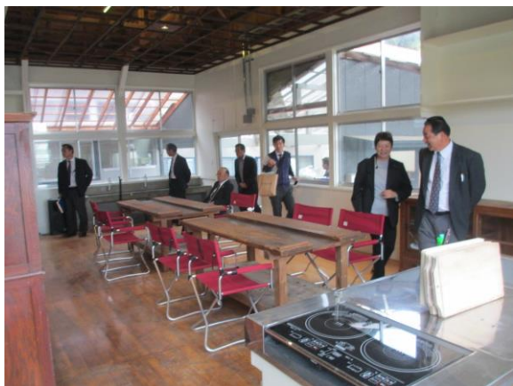
改装中のカフェホール
