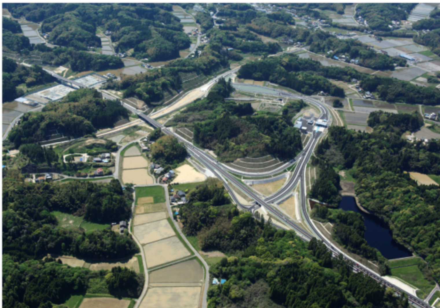
首都圏中央連絡自動車道 茂原長南インターチェンジ
