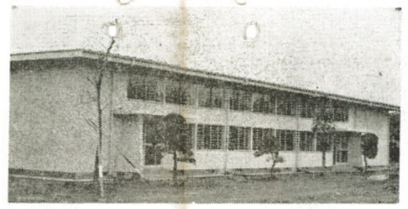
東小学校屋内運動場新築事業
