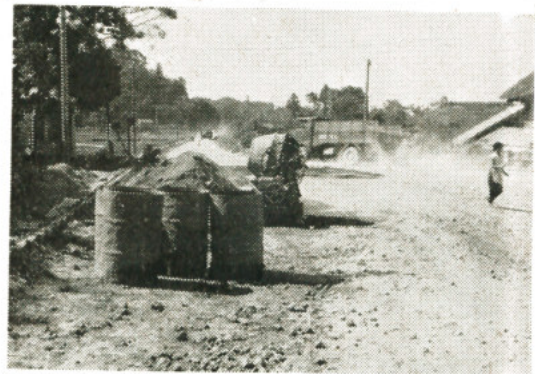
(工事中の千田地先)
