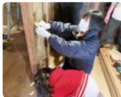
土壁の補修は粘土遊びのよう?! 細かい隙間を埋めるのは 子どもの手が大活躍でした！
