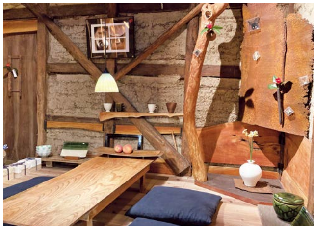
元々は納屋だった建物をギャラリーにリノベーション 荒壁を活かし、樫の切り落とし材や廃材をふんだんに使ったギャラリー
