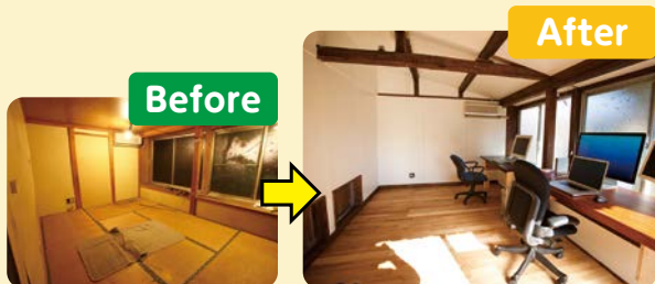
天井を抜き、構造材を露出させ空間を広くした
