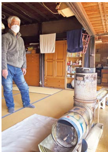
ロケットストーブで居間、 寝室を温められるよう配管の試験中
