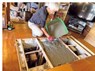
土間のロケットストーブの熱を オンドルの様に居間に引き込み床暖房に
