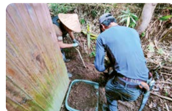
家の外周に、水はけをよくするための溝を掘ります。
