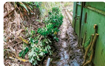
完成した柵(しがらみ)と溝。この溝で、建物の下の土に浸透する水を防ぎます。
