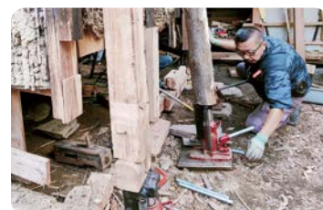
家の水平をもとに戻すため、ジャッキアップします。ここは傷んでいた柱の一部を交換しました。
