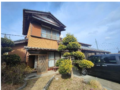
離れ兼倉庫外観
