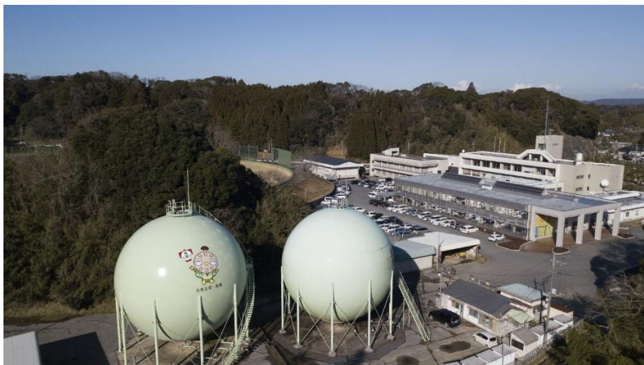
ドローンで撮影したガスタンク
