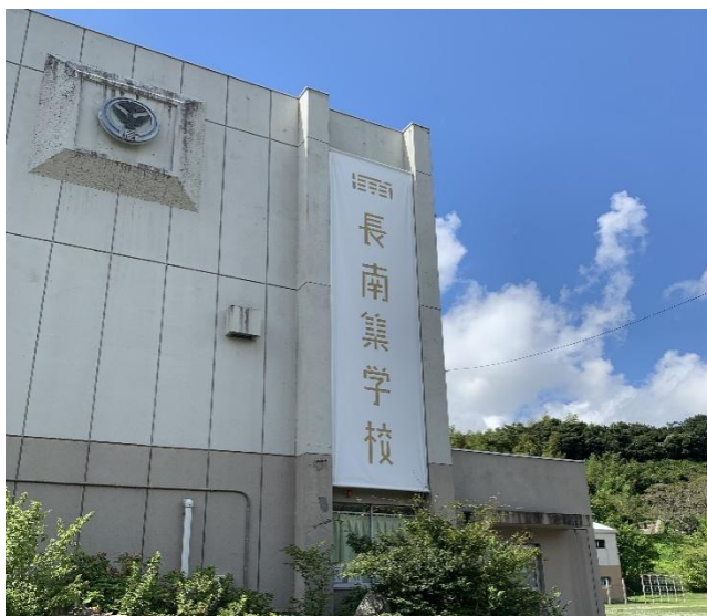
旧長南小学校を活用した IT 交流施設
